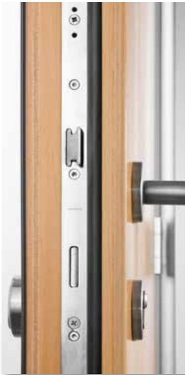
**Massiver Türaufbau mit durchgehender Schliebleiste**
